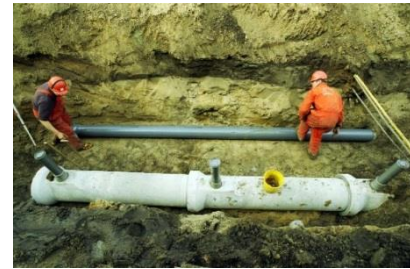
Figuur 2 Gescheiden rioelstelsel (RIONED)
