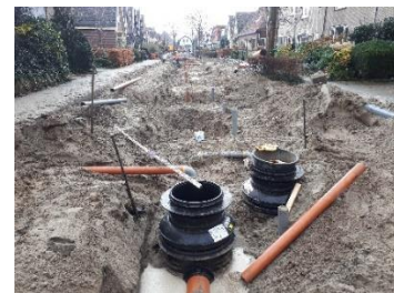
Figuur 1 Aanleg riolering
