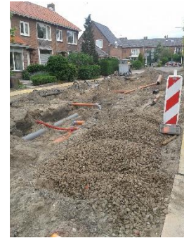
Figuur 4 Aanleg riolering
