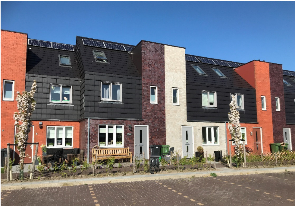
Kleinschalige uitbreiding aan Rubrum (Akersloot) met een eigentijdse vormgeving en individuele gevels per woning, maar met behoud van samenhang op woonblokniveau.
